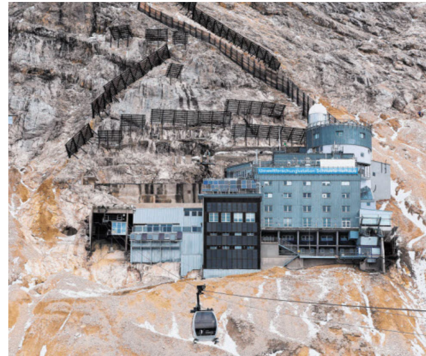
Stabile Gitter schützen das Schneefernerhaus vor Lawinenabgängen.
